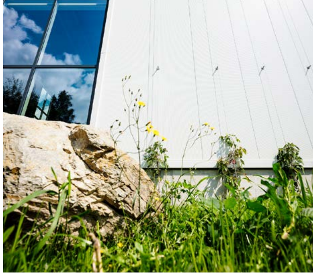
Europas modernstes Feinblechzentrum: Im Inneren sorgen wir mithilfe neuester Technologien, darunter Robotik, für eine hohe Produktions- und Materialeffizienz. In den Außenbereichen punktet die Umsetzung eines umfassenden Biodiversitätskonzepts.
