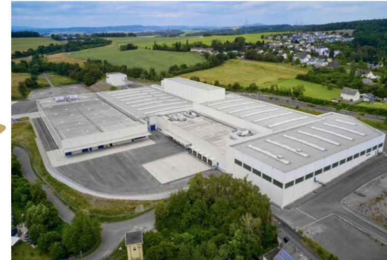
Das Projekt umfasste auch den Bau von drei Regenrückhaltebecken mit insgesamt rund 6.000 Kubikmeter Rückstauvolumen zur Entlastung der örtlichen Infrastruktur. Das Entwässerungskonzept berücksichtigt darüber hinaus eine Erweiterungsfläche von etwa 8.500 Quadratmetern.
