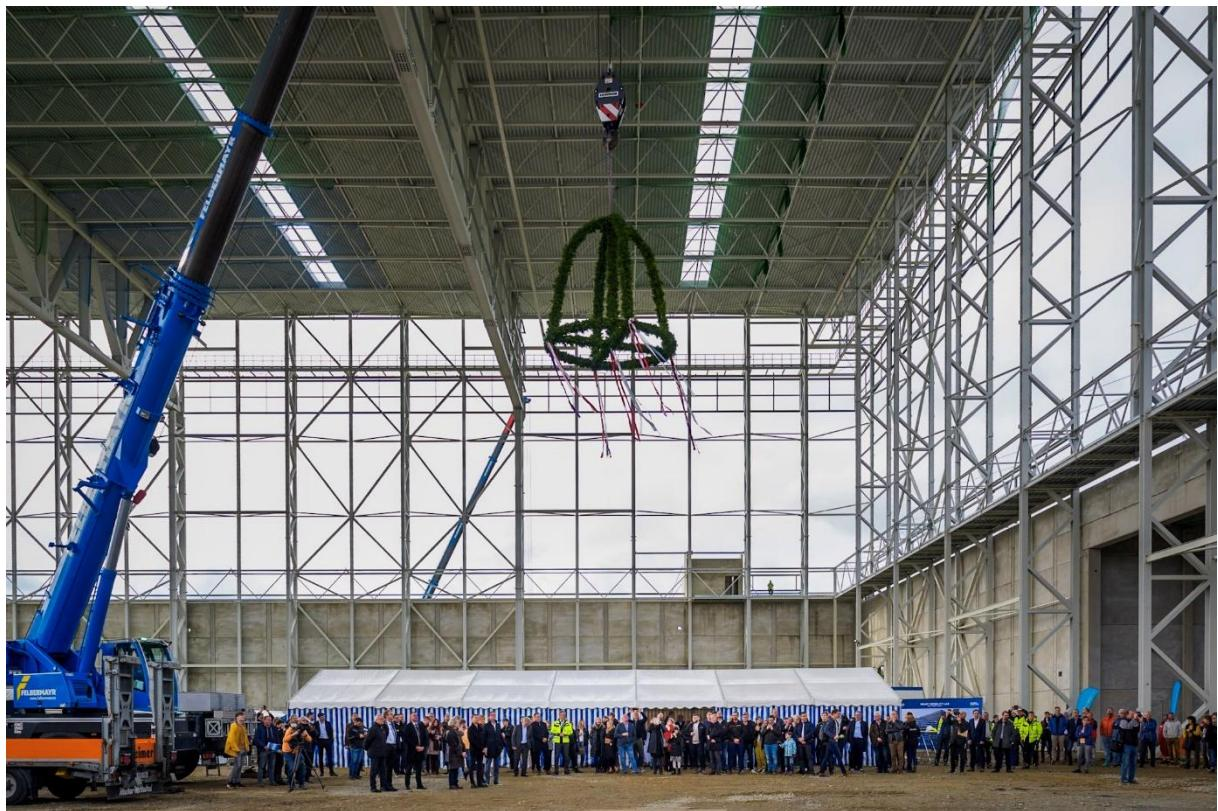
**Bildbeschreibung:** Die bis zu zehn Meter hohen und 100 Meter langen Stahlbinder für die Drohnenflughalle wurden in der Lausitz vorgefertigt, für den Transport zerlegt und vor Ort wieder zusammengesetzt.
