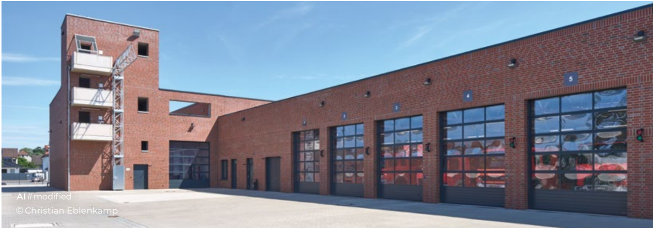
Freiwillige Feuerwehr, Holzminden BGF: 4.500 m² Fertigstellung: 2024
