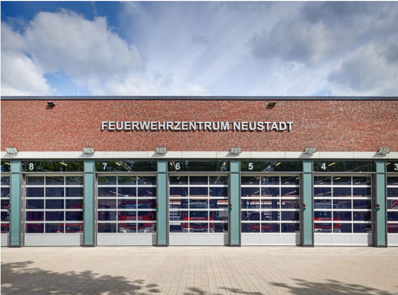
Feuerwehrtechnisches Zentrum, Neustadt am Rübenberge BGF: 9.700 m 2 Fertigstellung: 2020
