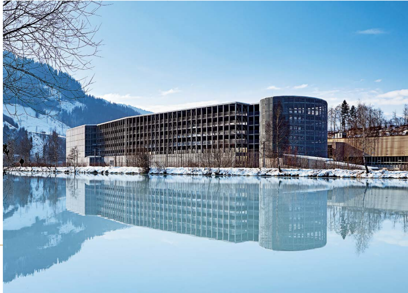
Liebherr-Werk Bischofshofen GmbH, Bischofshofen, Austria, seven levels, 635 parking spaces
