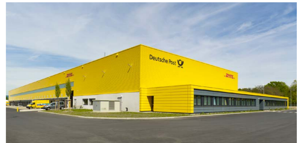
DHL MechZB, 53117 Bonn, Logistikhalle mit 6.710 m² und Büroanbau mit 380 m² BGF
