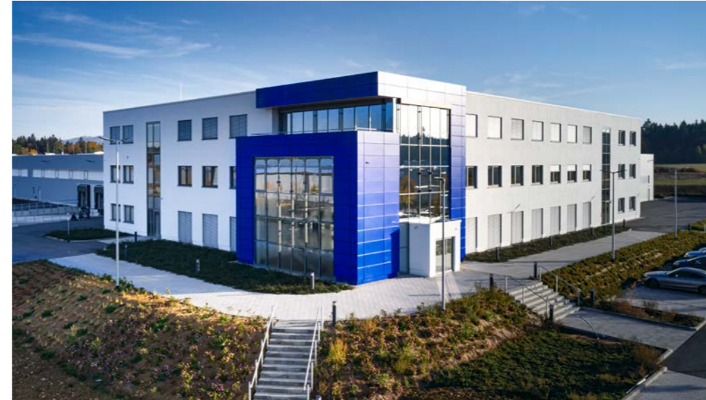
MZA Meyer-Zweiradtechnik GmbH, 98617 Meiningen Logistikimmobilie mit 13.000 m 2 und angeschlossene Büro- und Sozialräume mit 2.220 m 2 BGF
