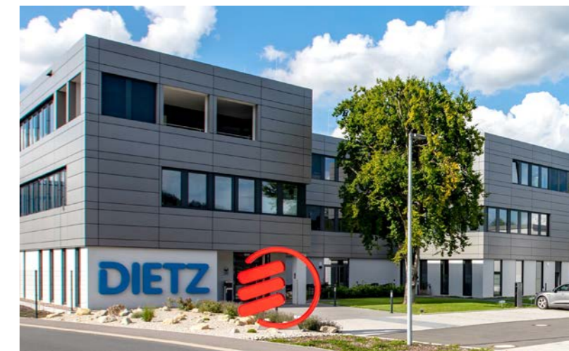
Dietz GmbH, 96465 Neustadt b. Coburg Bürogebäude mit 1.864 m 2 BGF
