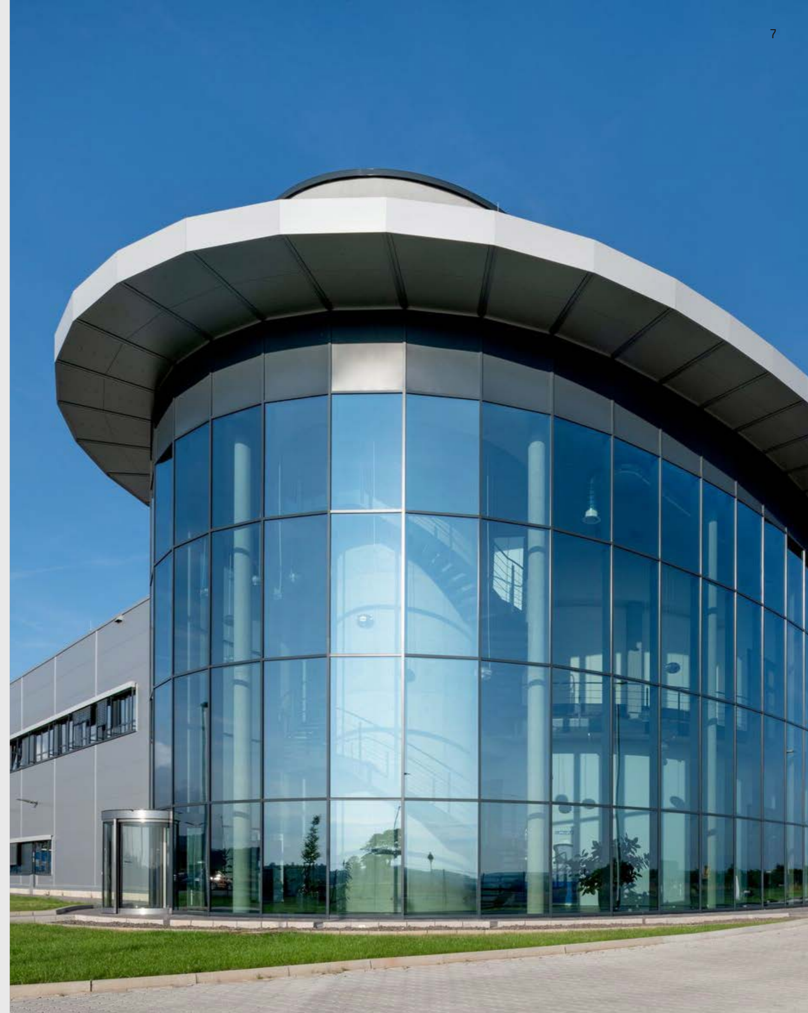
CARLISLE® Construction Materials GmbH, 99880 Waltershausen Produktionshalle mit 9.600 m 2 und Bürogebäude mit 1.460 m 2 BGF
