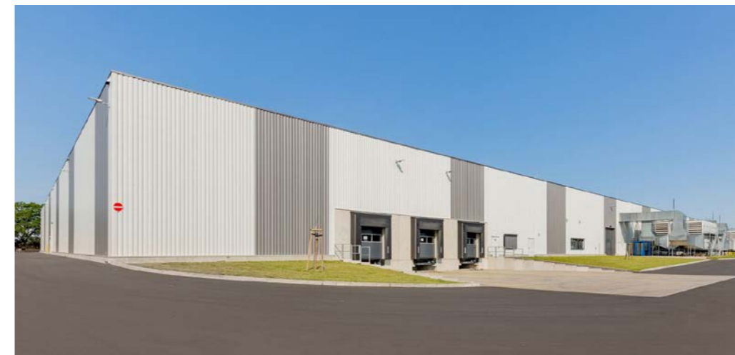
Fritz Winter, 35260 Stadtallendorf, Produktionshalle mit 17.100 m 2 und Büroanbau mit 1.312 m 2 BGF
