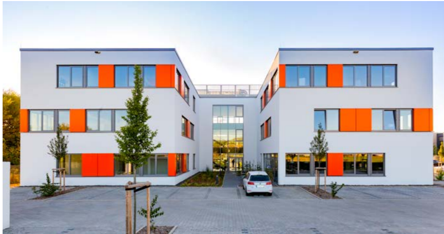
HBH Telemedia, 35083 Wetter, Bürogebäude mit 4.350 m 2 BGF
