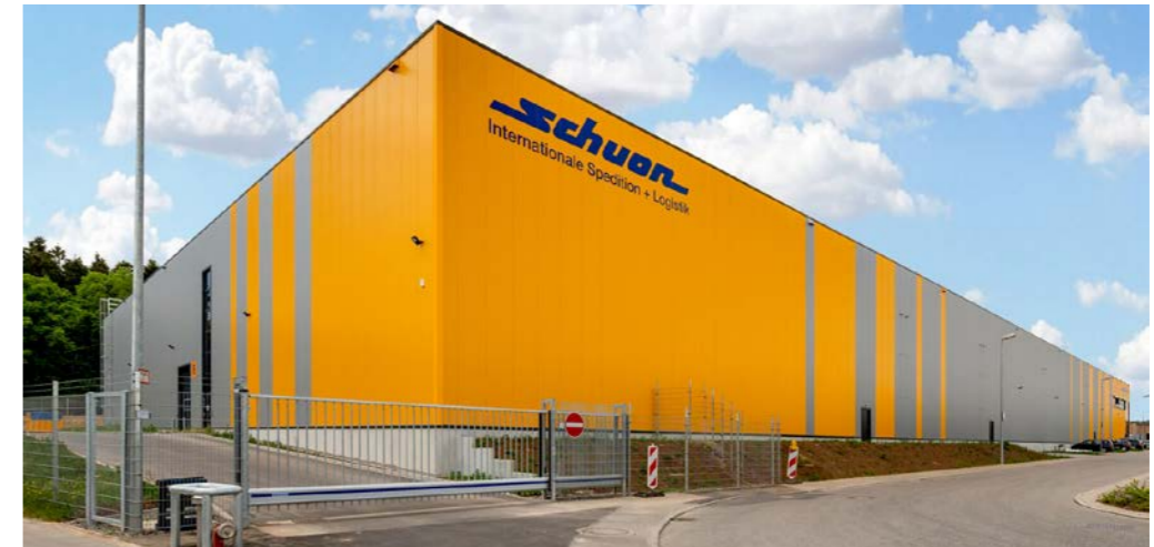
Schuon, 72218 Wildberg, Logistikhalle mit 8.764 m 2
