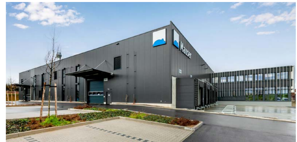
Mauser, 71254 Ditzingen, Bürogebäude mit 1.414 m 2 BGF und Produktionshalle mit 6.217 m 2
