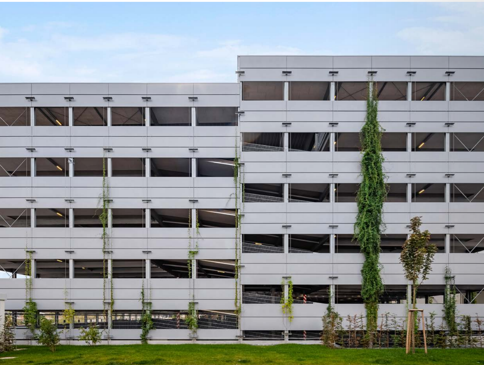
Parkhaus DIBAG, 70372 Stuttgart mit 308 Stellplätzen
