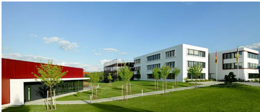
Mink Campus, 73035 Göppingen, Bürogebäude mit 3.180 m 2 BGF, Halle mit 2.730 m 2 und Parkhaus mit 152 Stellplätzen
