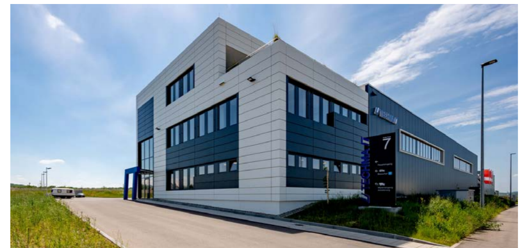
Techma, 72622 Nürtingen, Bürogebäude mit 672 m 2 BGF und Produktionshalle mit 2.381 m 2
