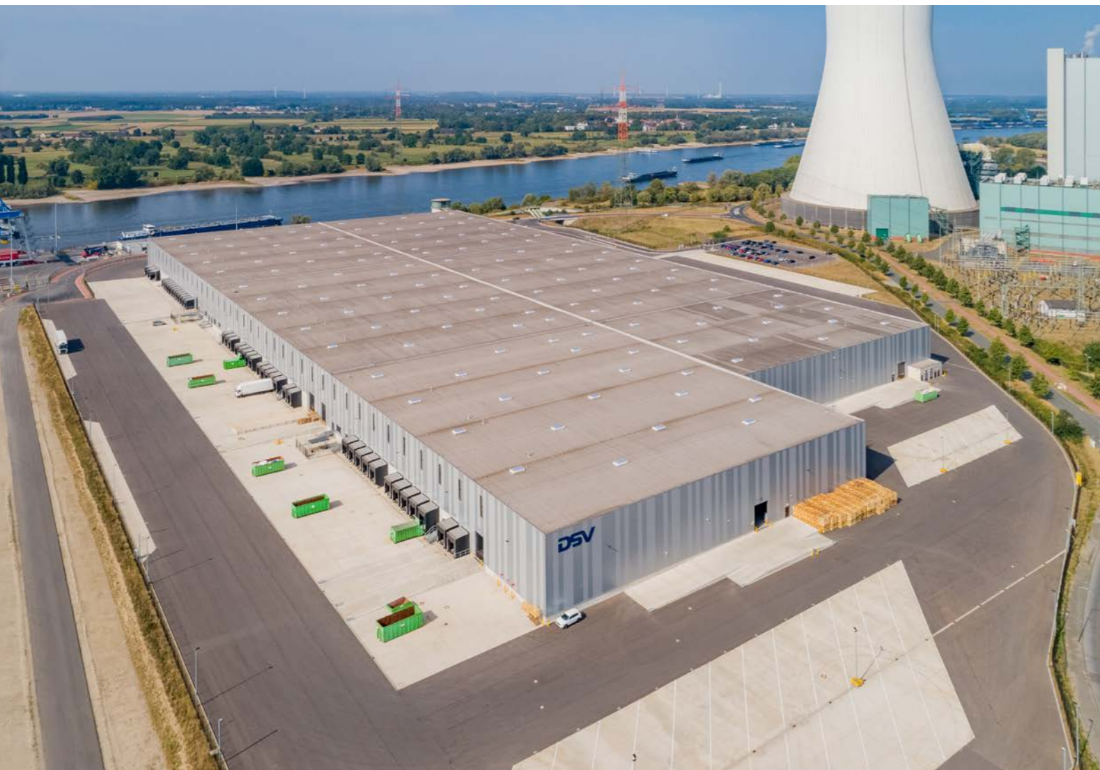
DSV, 47179 Duisburg, Bürogebäude mit 1.600 m 2 BGF und Logistikhalle mit 54.000 m 2
