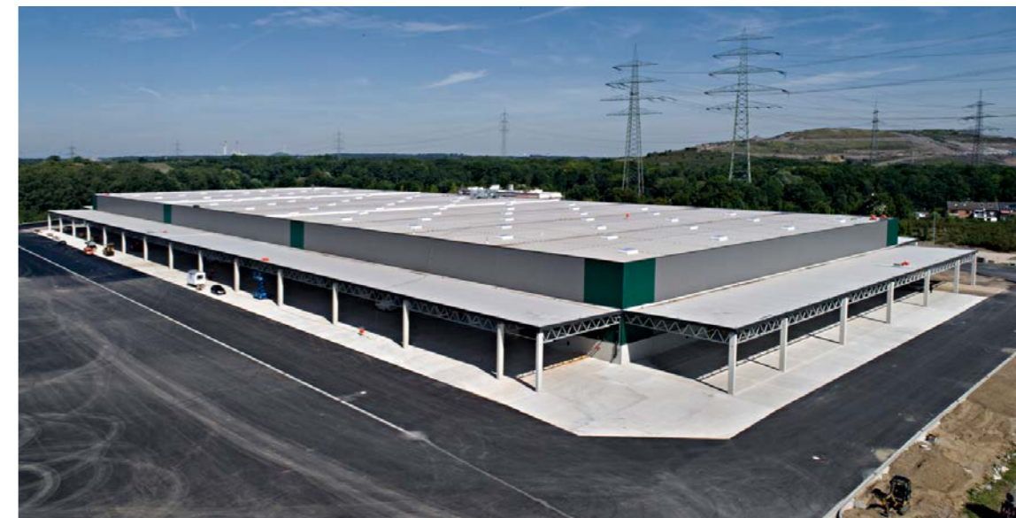
Harpn-Duvenbeck, 44653 Herne, Bürogebäude mit 2.000 m 2 BGF und Logistikhalle mit 25.400 m 2
