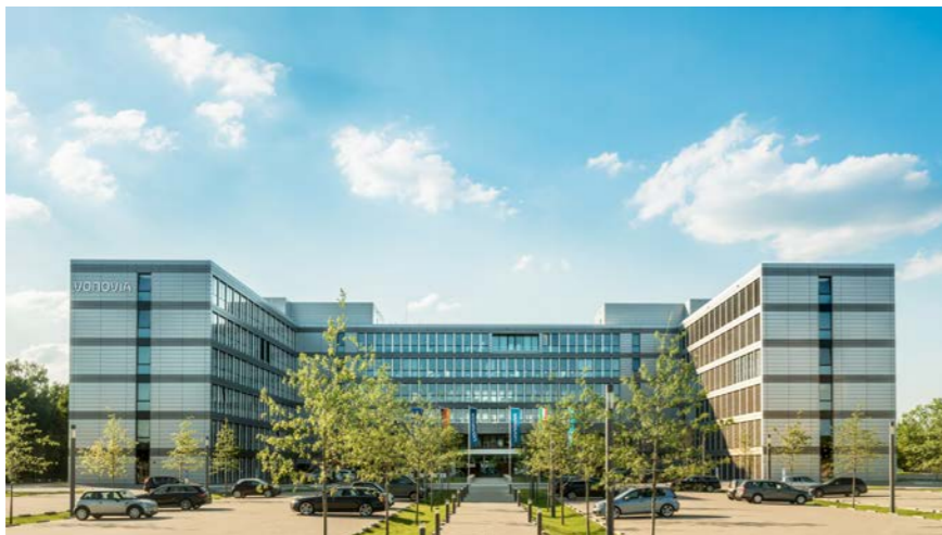
VONOVIA Unternehmenszentrale, 45127 Bochum, Bürogebäude mit 29.484 m 2 BGF
