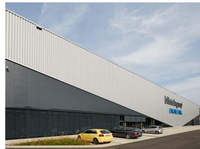
febi, 58256 Ennepetal, Produktionshalle mit 13.100 m 2 und Büroeinbauten mit 2.500 m 2
