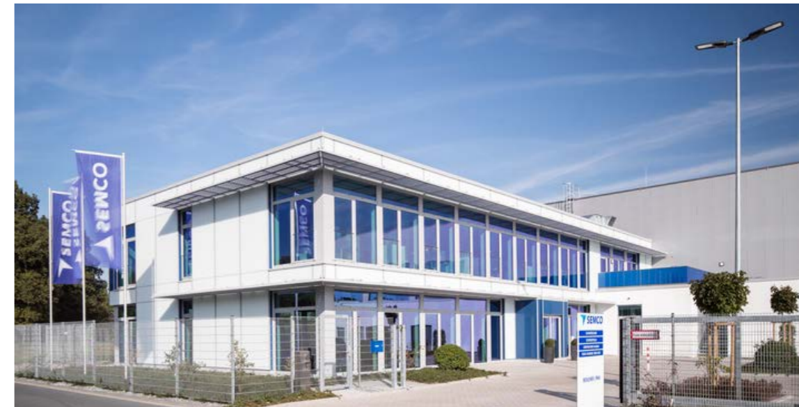
Semcoglas, 26160 Bad Zwischenahn, Bürogebäude mit 1.390 m 2 BGF und Produktionshalle mit 4.600 m 2
