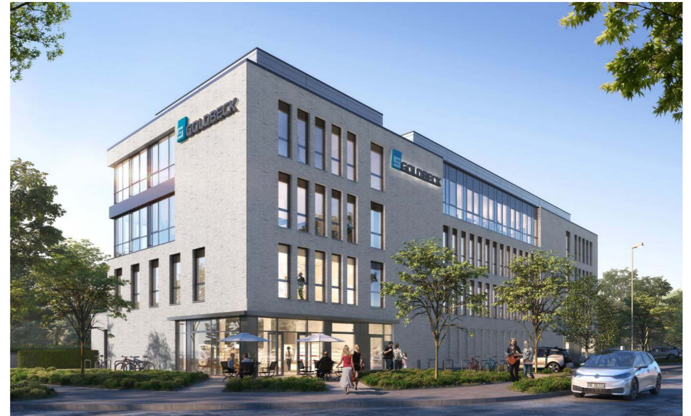
Weser-Wohnbau, 28355 Bremen, Bürogebäude mit 4.270 m 2 BGF (Standort der GOLDBECK Niederlassung Bremen)
