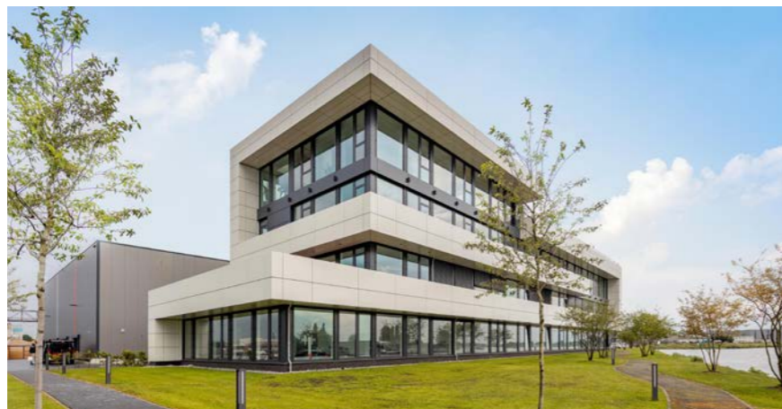
P&S, 28309 Bremen, Bürogebäude A7 mit 2.450 m 2 BGF und Halle A6 mit 2.750 m 2
