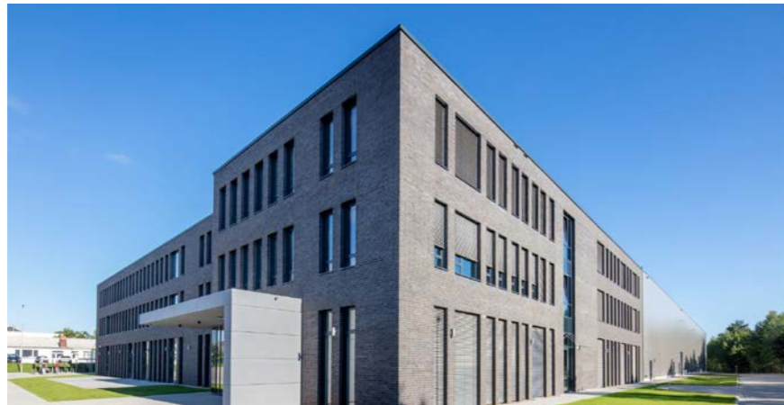
Desma, 28832 Achim, Bürogebäude mit 1.800 m 2 BGF und Produktionshalle mit 13.000 m 2
