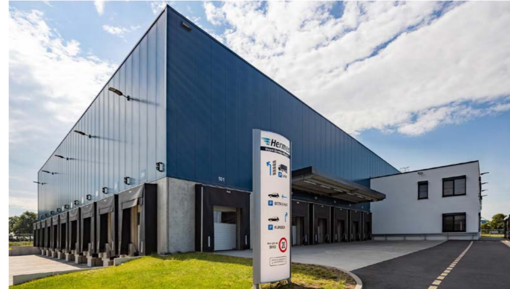
Hermes Depot, 28844 Weyhe, Logistikhalle mit 5.000 m 2 und Büroanbau mit 550 m 2 BGF
