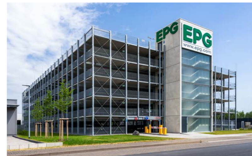
Parkhaus C.O.M., 56072 Koblenz mit 456 Stellplätzen
