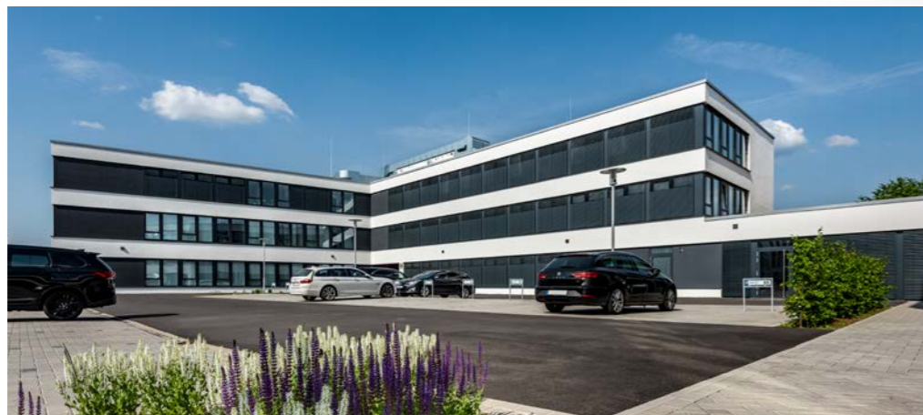
Center of Motion, 56072 Koblenz, Bürogebäude mit 8.000 m 2 BGF
