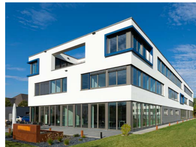
Verheyen, 55543 Bad Kreuznach Bürogebäude mit 3.000 m 2 BGF und Halle mit 240 m 2
