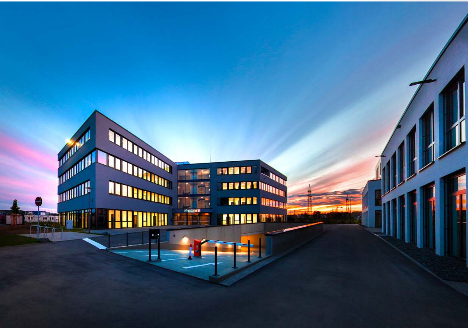
HBB Lubberich Projects im Technologiepark, 56070 Koblenz-Bubenheim Bürogebäude mit 4.770 m 2 BGF
