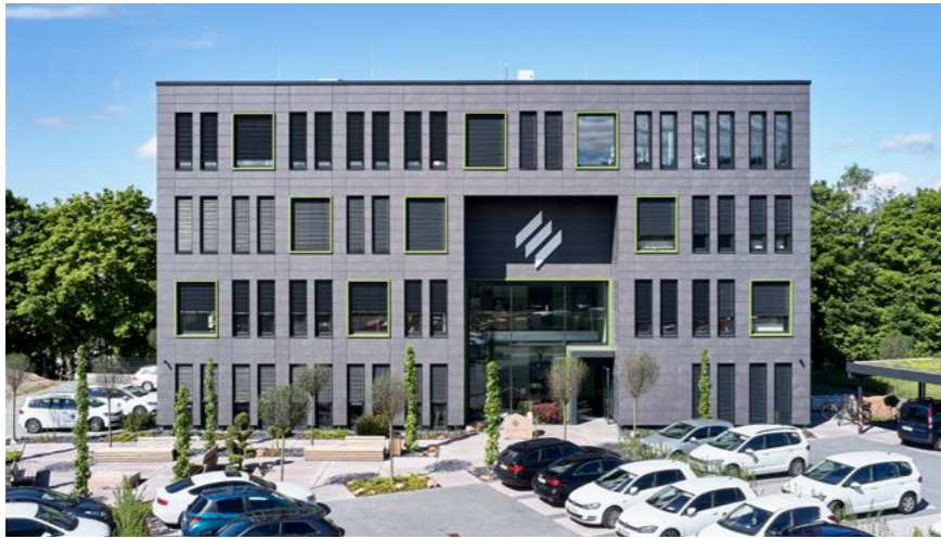
Deutsche Reihenhäuser, 67657 Kaiserslautern, Bürogebäude mit 1.780 m 2 BGF
