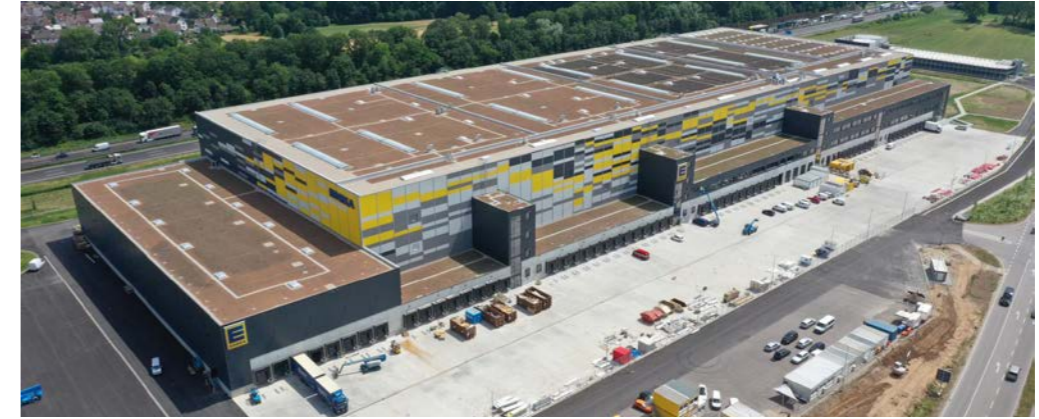
EDEKA, 76437 Rastatt, Logistikhalle mit 100.000 m 2 BGF (3-geschossig) und Parkhaus mit 311 Stellplätzen
